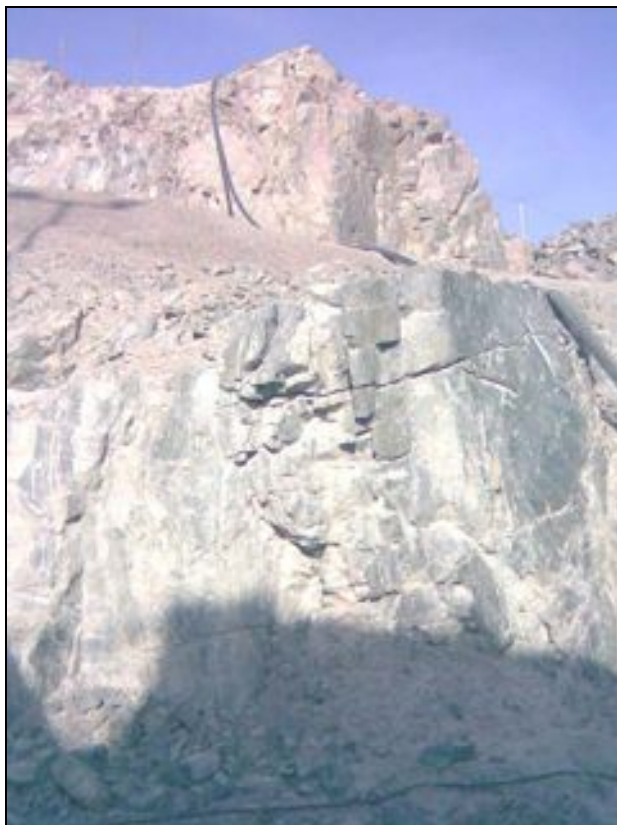
Kuva 10.3. Kallion rakoilu on vähäistä ja raot kapeita ja epäjatkuvia, mistä syystä kalliopohjave- den muodostuminen on vähäistä ja veden liike hidasta. Kuvan yhteensä noin 20 metriä korkea porrasmainen kallioseinämä pysyy kuivana. Kuvassa näkyvää letkua pitkin pumpataan tasolle +37 m perustettuun kalliokaukaloon kertyvää sadevettä. Kuva on otettu 21.4.2009.
