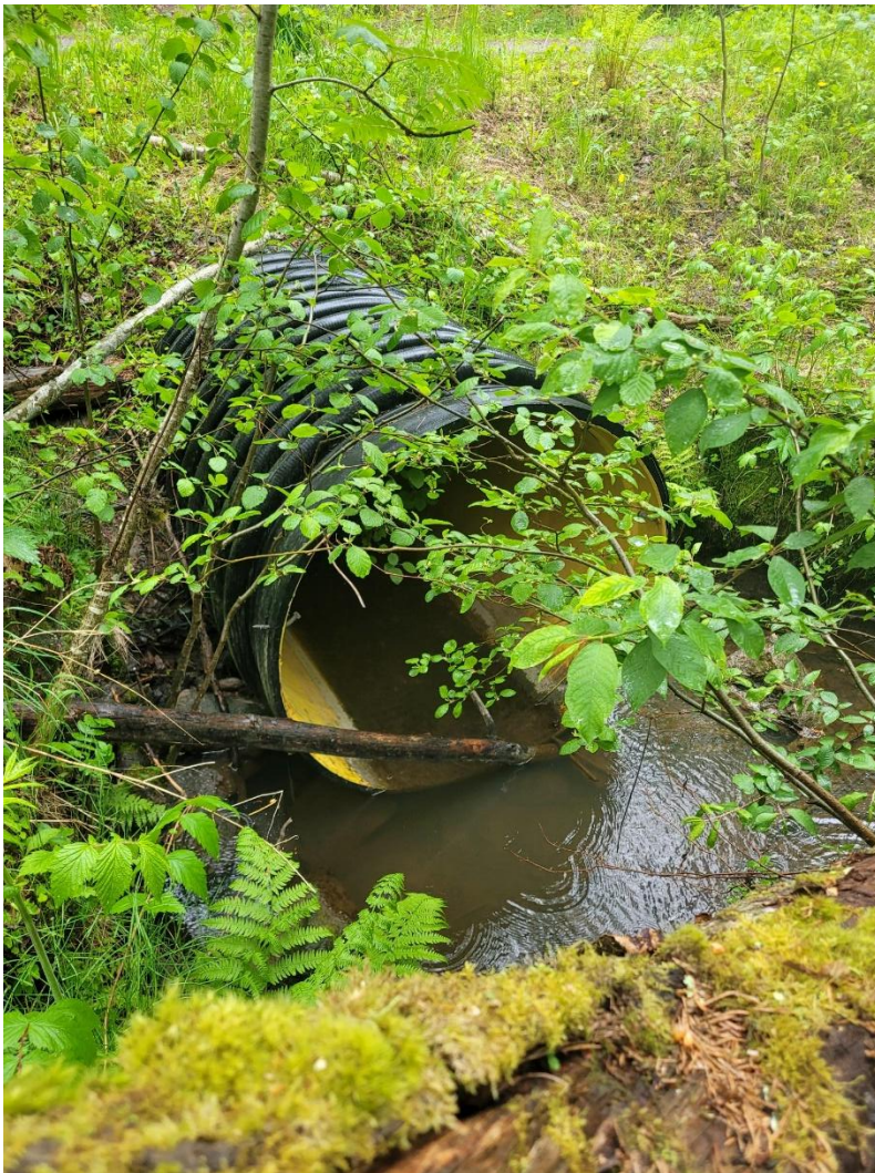
Kuva 3-18. Jakso 5 päättyy rumpuun.
