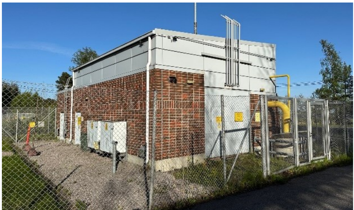
Bild 3-4. Tryckreduceringsstation.
