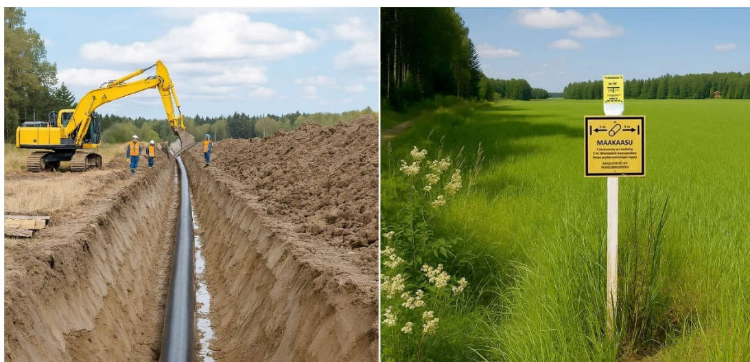
Bild 3-7. Bilder på installation av en naturgasledning. Rördike och nedläggning av rör på åker, samt åkern efter anläggnings- och återställningsarbeten, fotograferad året efter.
