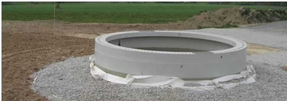
Kuva 3-10. Perustuksen rakentamisvaiheita. (Kuva: Ventureal).
