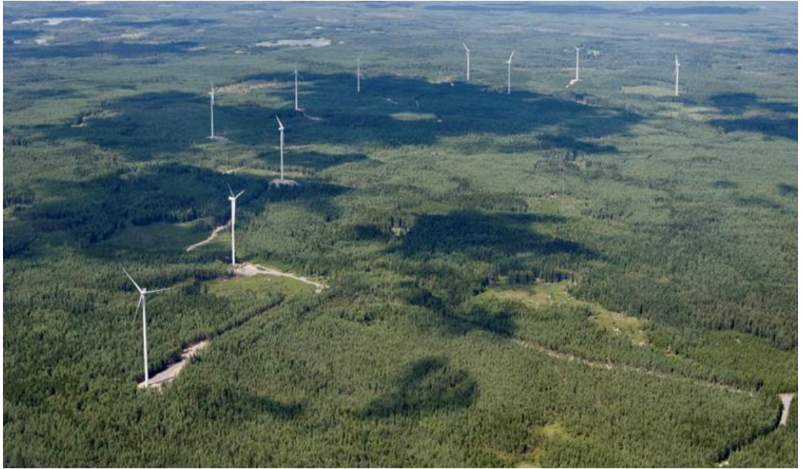
Kuva 3-6. Tuulivoimapuisto metsäisellä alueella. Stengårdsholman tuulivoimapuisto Ruotsissa, 10 voimalaa à 2 MW, napakorkeus 125 m, roottorin halkaisija 90 m. (Kuva: E.ON).
