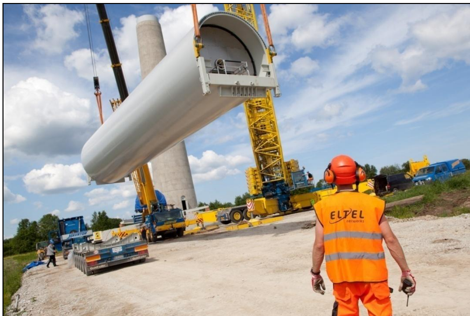
Kuva 3-15. Tornilohkon nostaminen (Kuva: Eltel Networks Oy).
