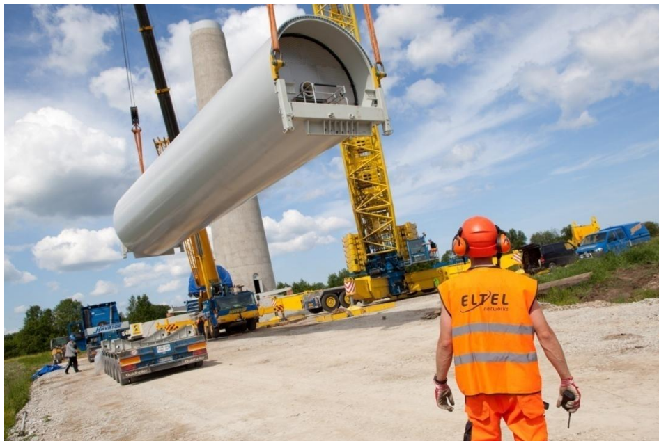
Kuva 3-14. Tornilohkon nostaminen (Kuva: Eltel Networks Oy).
