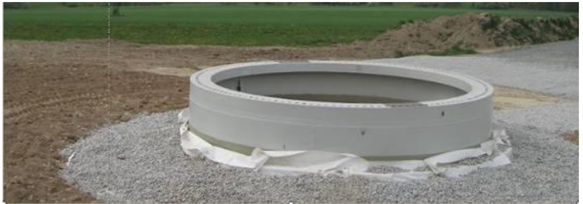
Kuva 3-10. Perustuksen rakentamisvaiheita. (Kuva: Ventureal).
