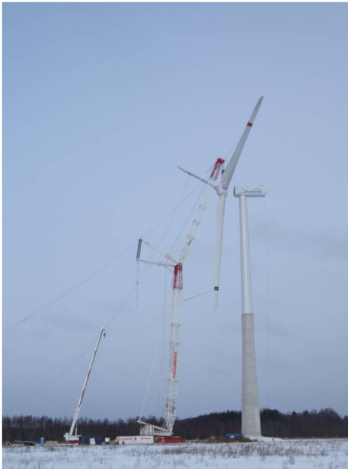
Kuva 3-7. Kuva teräsbetonirakenteisen tuulivoimalan pystytyksestä.
