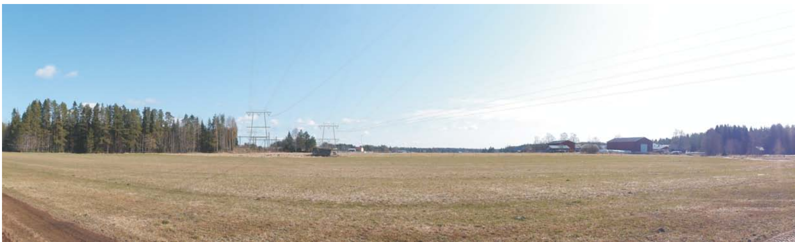
Kuva 23. Havainnekuva tulevasta tilanteesta Jylkän peltoaukealla. Kuvassa tuleva 400 kV voimajohto sekä yhteispylvääseen tulevat tuulivoimapuistojen 110 kV voimajohto ja 220 kv korvaavan 110 kV voimajohdot.
