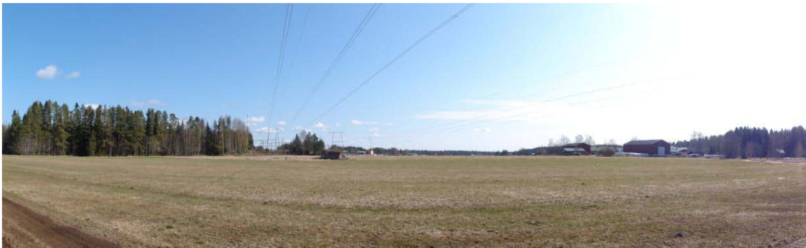
Kuva 22. Nykyiset voimajohdot Jylkän peltoaukealla
