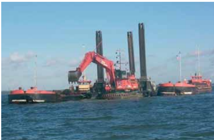
Kuva 4-10. Kuokkakauharuoppausta Vuosaaren satamassa (FCG Planeko Oy/M. Vähäkäkelä).
