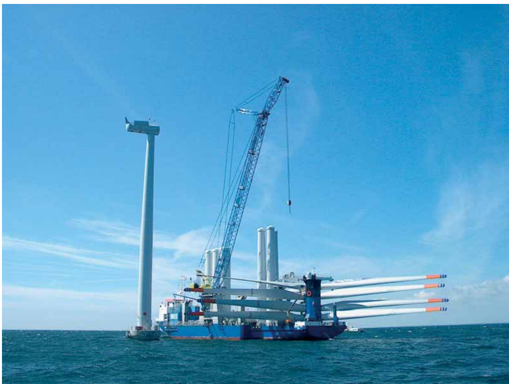
Kuva 4-7. Esimerkki tuulivoimaloiden asennukseen käytetystä aluksesta. Kuva: wpd
