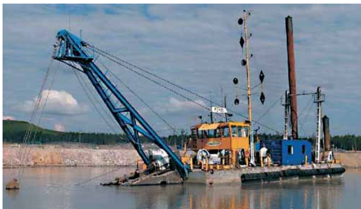
Kuva 4-9. Kuva imuruoppaajasta "Pekka 1" (Terramare Oy).
