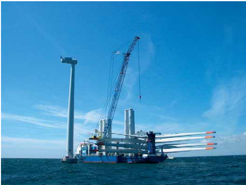
Kuva 7-93. Esimerkki tuulivoimaloiden asennukseen käytetystä aluksesta. © wpd
