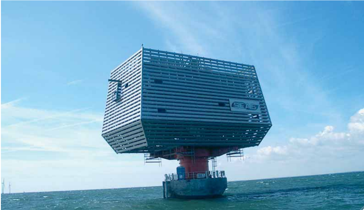
Kuva 4-5. Esimerkki 160 MW tehoisesta merisähköasemasta betonikasuuniperustuksella. Kuva: wpd
