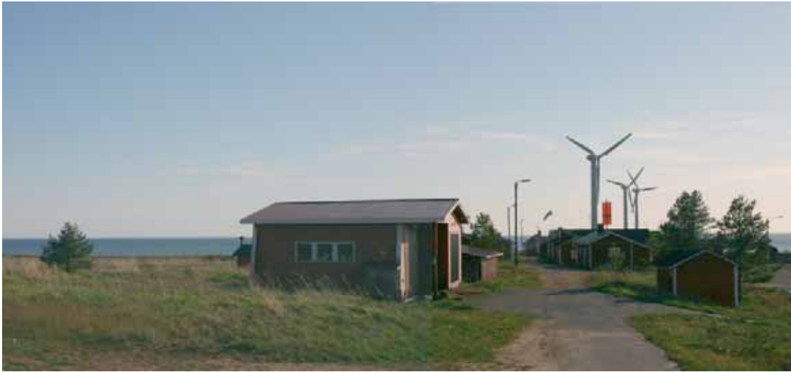
Kuva 7-39. Nykyistä tuulivoimarakentamista Hailuodon Marjaniemen kulttuuri- ja luonnonmaisemassa. Kuva: Elina Kataja, Pöyry
