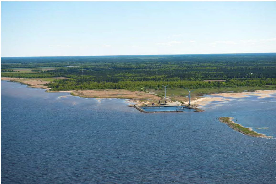
Kuva 70. Lähempi kuva mereltä päin kohti voimaloita ja satamaa.
