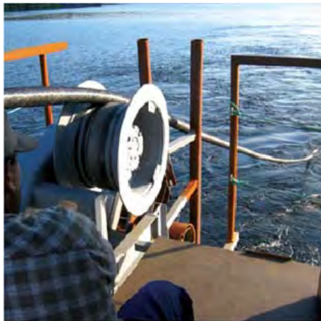
Kuva 15. Merikaapelin laskua asennusalukselta sekä merikaapelin rantautumispaikka. (Kuvat Prysmian, Tuulipuistokaapelit –esite)
