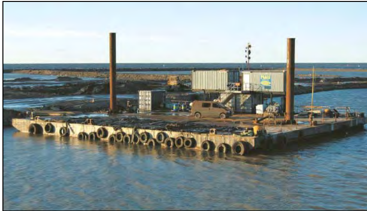
Kuva 39. Paalutuskone Paalu. (Terramare Oy)
