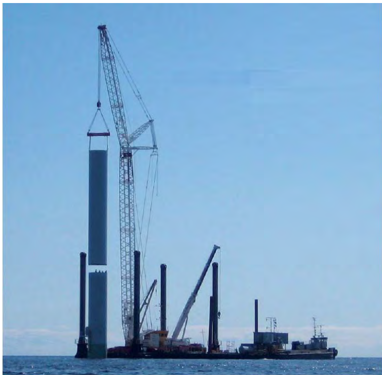
Kuva 32. Koetuulivoimalan tornin pystytys Kemin Ajoksessa. (Terramare Oy)
