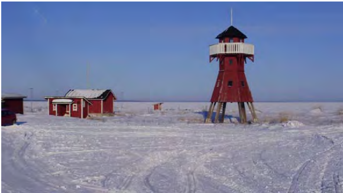
Kuva 81. Varessäikän lintutorni, taustalla näkyy Hailuoto. (Kuva WSP 2010)
