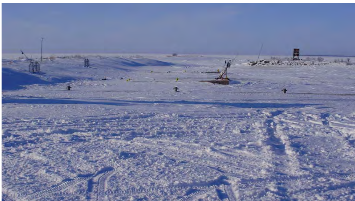
Kuva 79. Varessäikän satama-allas. (Kuva WSP 2010)
