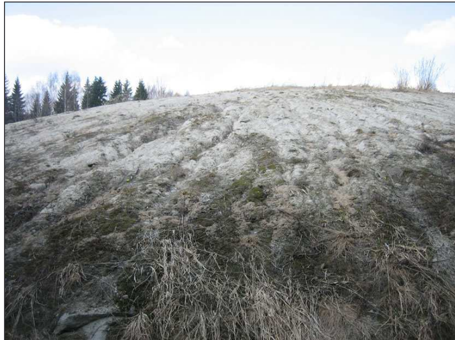
Kuva 26. Viljakkalan suljettu kaatopaikka 3.5.2006.
