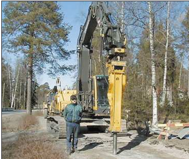
Kuva 13. Iskuvasaralla varustettu kaivinkone 11 .
