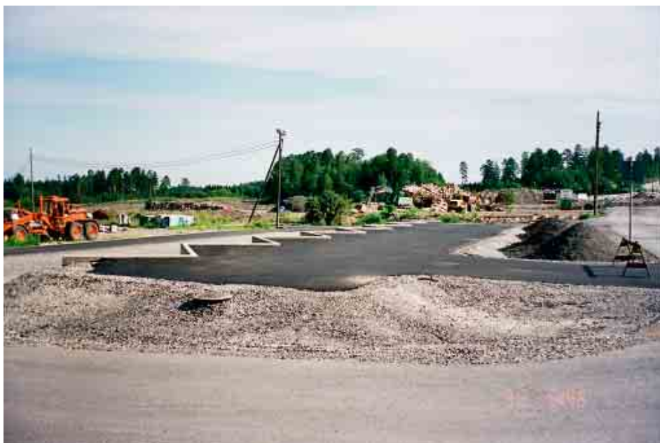
Kuva 3.15 Jätteen pientuojien vastaanottolaituri Metsä-Sairilan jäteasemalla
