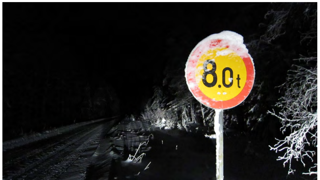
Kuva 7. Rullan metsätie on vahvistettava. Tien ajoneuvojen suurin sallittu massa on 8 t, kun tuulivoimalan konehuone yksin voi painaa yli 120 t (Kuva J. Kjellman).
