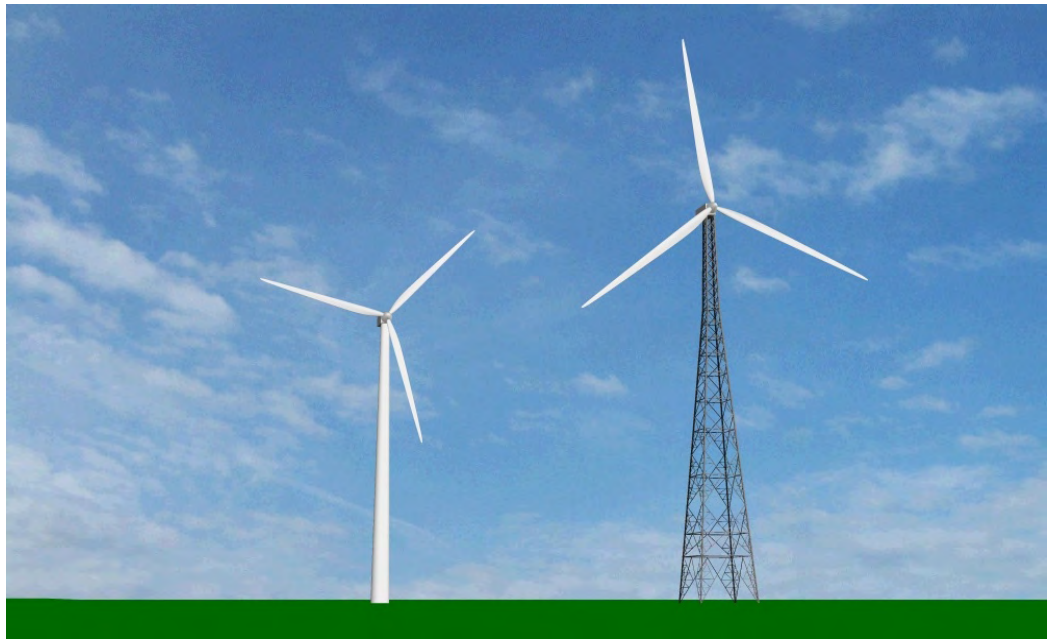
Kuva 6. Esimerkki 120 m lieriörakenteisesta tuulivoimalaitoksesta, jossa on 110 m roottori sekä 150 m ristikkorakenteista tornista 150 m roottorilla.
