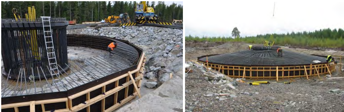
Kuva 2-16. Vasemmalla kallionvarainen perustus, oikealla maanvarainen perustus, Putaankangas (Kuvat: TuuliWatti).
