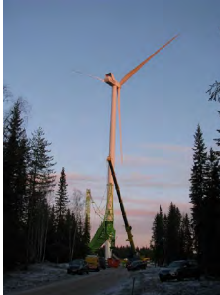
Kuva 2-18. Tuulivoimalan pystytys Simon Putaankankaalla. Kuvassa teräslieriötorni. (Kuvat: TuuliWatti)
