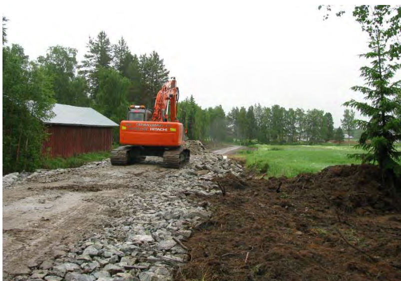
Kuva 2-14. Tiestön rakentamista Simon Putaankankaalla (Kuva: TuuliWatti).
