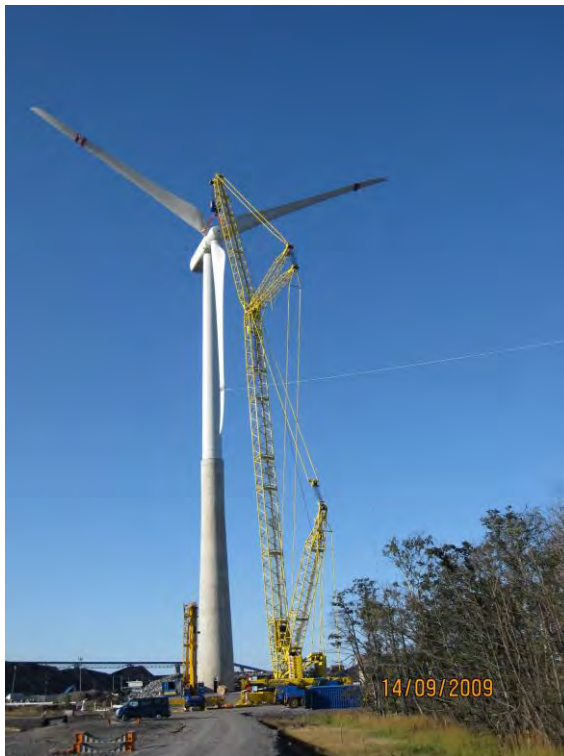
Kuva 2-19. Kuva betoni-/teräslieriötornin (ns. hybriditorni) rakentamisesta. Tämän tornin napakorkeus on 100 metriä ja siiven pituus 50 metriä. (Kuva: TuuliWatti)
