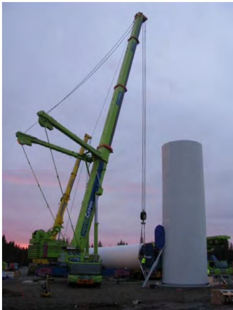
Kuva 2-18. Tuulivoimalan pystytys Simon Putaankankaalla. Kuvassa teräslieriötorni. (Kuvat: TuuliWatti)
