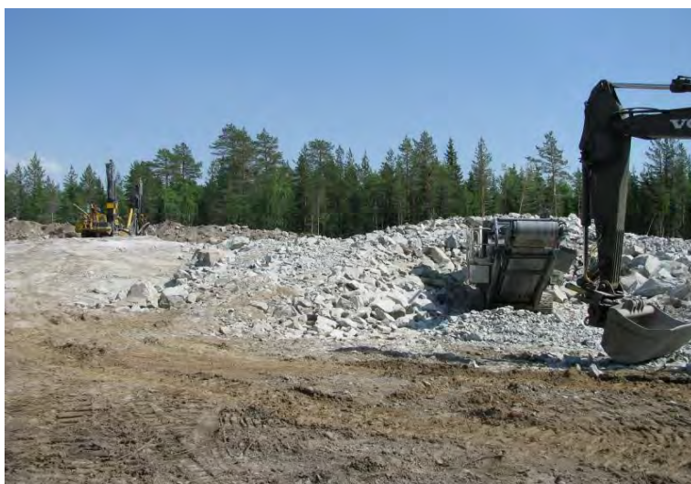
Kuva 2-15. Infran rakentamista Simon Putaankankaalla (Kuva: TuuliWatti).
