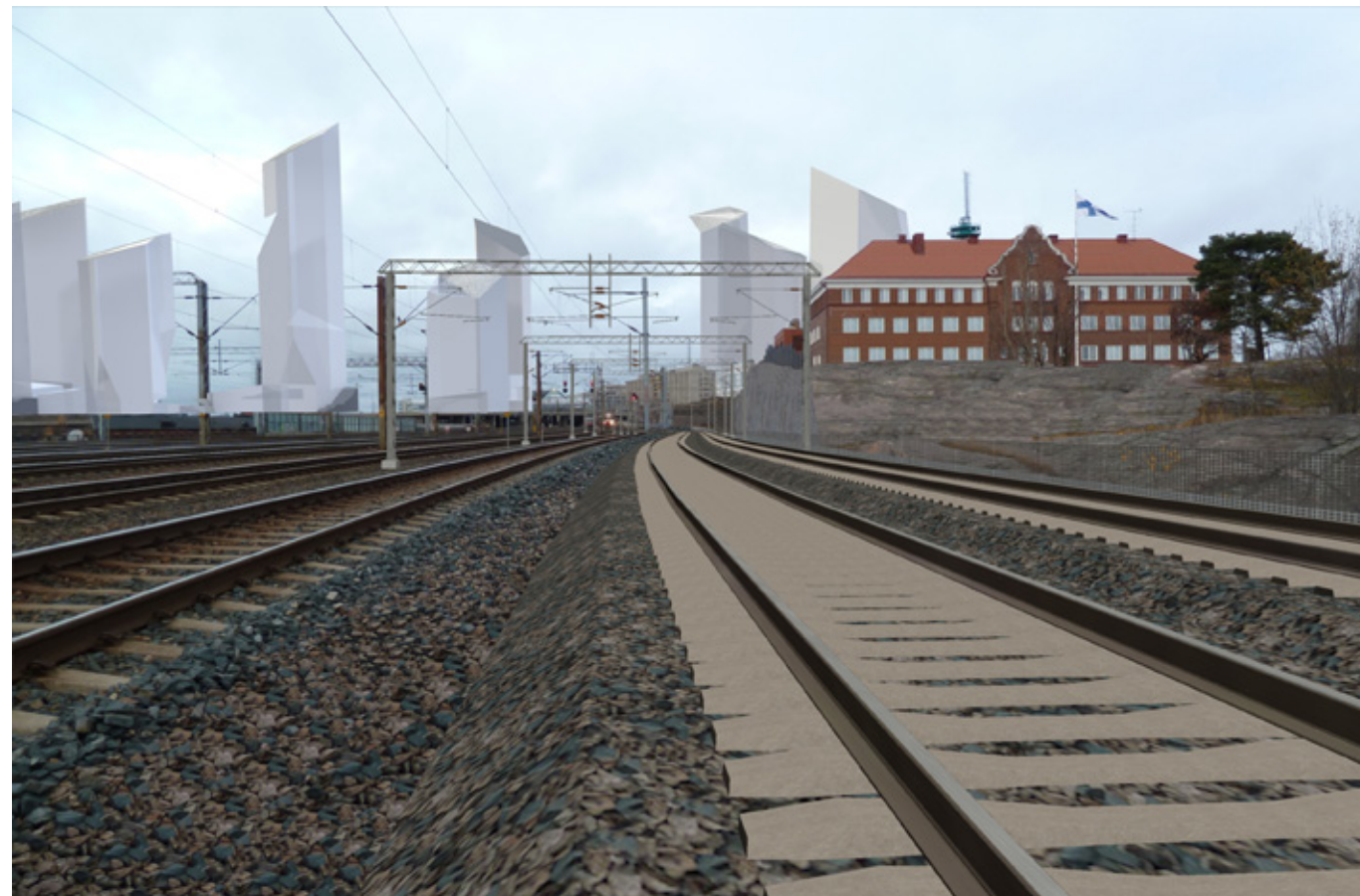
Kuva 6.48. Havainnekuva Pasilan eteläpuolelta vaihtoehdosta 1, jossa uudet raiteet sijoittuvat nykyisten itäpuolelle. Eläintarhan ala-asteen koulu näkyy kuvassa oikealla. Kalliota joudutaan louhimaan pihan länsireunasta, kun rata on lopullisessa laajuudessaan. Kevyen liikenteen väylä siirtyy itään päin uuden raiteiston viereen.
