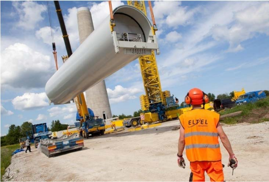
Kuva 19. Tornilohkon nostaminen (Kuva: Eltel Networks Oy)
