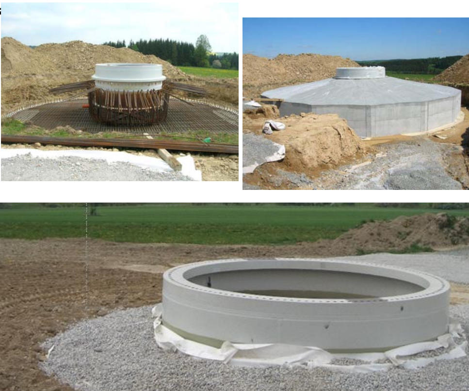
Kuva 6. Perustuksen rakentamisvaiheita ( Ventureal )
