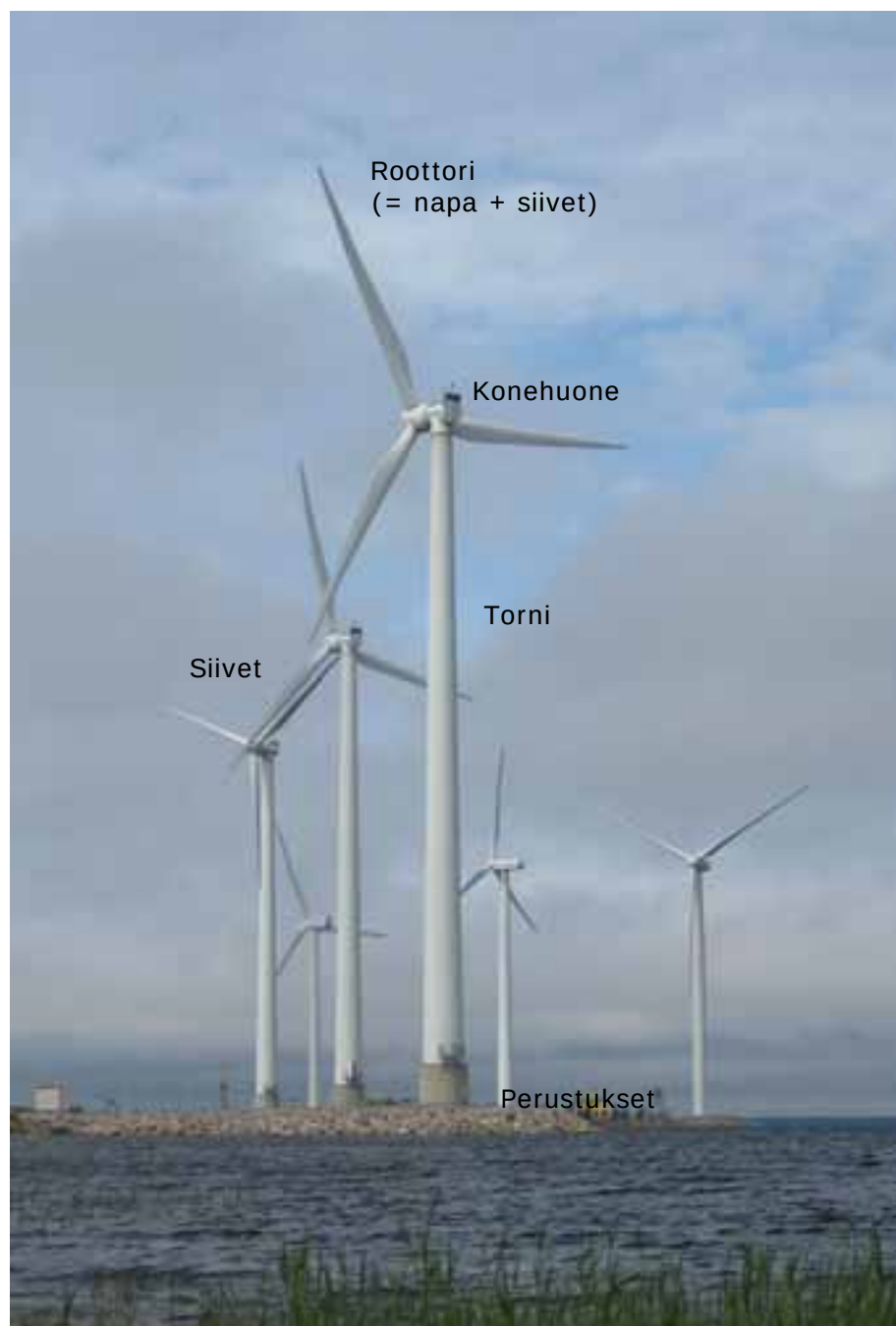
Kuva 5. Tuulivoimalan rakenne.
