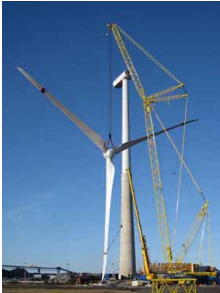
Kuva 3. Tahkoluodon tuulivoimala rakennusvaiheessa.
