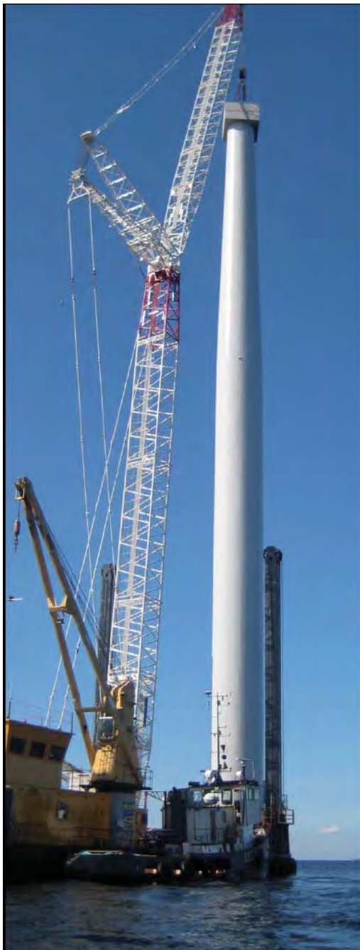
Kuva 4-26 Monopile –perustukseen asennetaan koetuulivoimalan mastoa Kemin Ajoksessa (Terramare Oy 2009).
