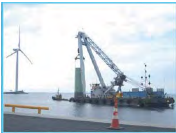
Kuva 4-23 Monopile –teräsputken kuljetus työlautta Paalulla (Terramare Oy 2009).
