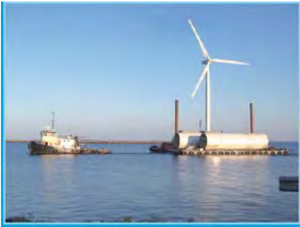
Kuva 4-24 Mastoelementin kuljetus työlautta Paalulla (Terramare Oy 2009).
