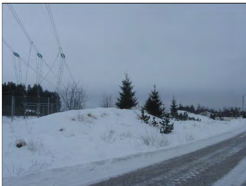
Kuva 4-22 Esimerkki maisemoidusta Tyrnävän sähköasemasta (Oulun Seudun Sähkö).
