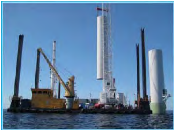
Kuva 4-25 Monopile –teräsputken nosto Playmate nosturialustalta (Terramare Oy 2009).
