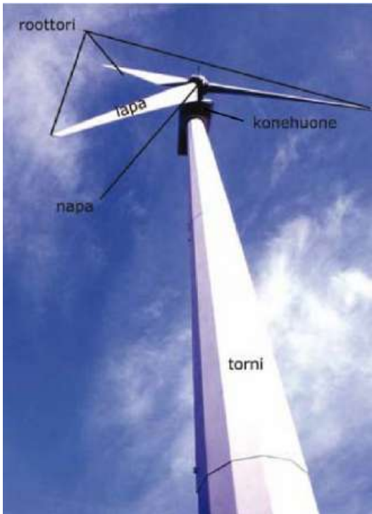
Kuva 11. Tuulivoimalan näkyvät osat (Weckman 2006).
