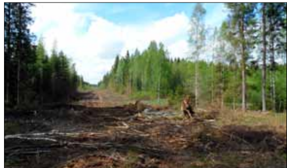
Kuva 11-24 Huoltotie tuulivoimaloiden 23 ja 26 välillä.
