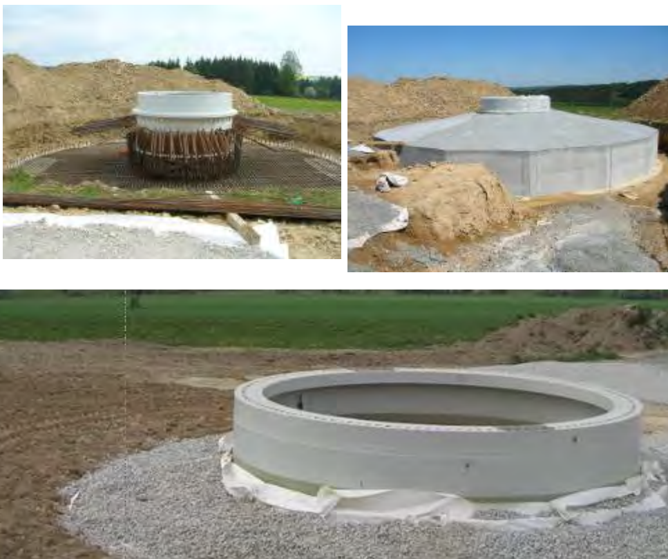
Kuva 3-5. Perustuksen rakentamisvaiheita (Kuva © Ventureal).
