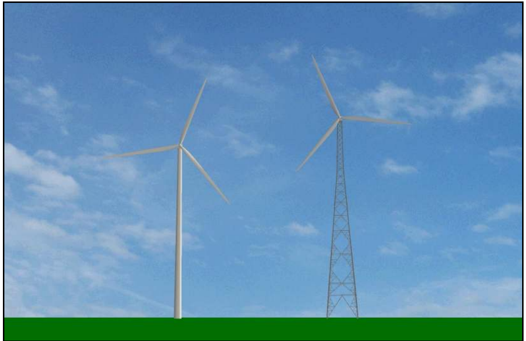
Kuva 4. Esimerkki 125 m korkeasta teräslieriötornilla varustetusta voimalaitoksesta, missä roottoriympyrän halkaisija on 120 m (siipi 60 m, kokonaiskorkeus 185 m) sekä 145 m korkealla teräsristikkorakenteisella tornilla varustetusta voimalaitoksesta, missä roottoriympyrän halkaisija on 110 m (siipi 55 m, kokonaiskorkeus 200 m).
