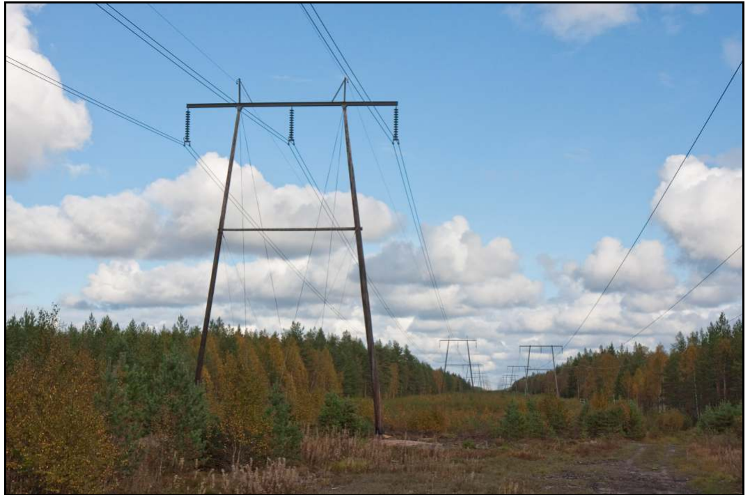
Kuva 10. Nykyinen Ventusneva – Kalajoki 220 kV ilmajohto on kuvassa vasemmalla puolella ja samalla johtoalueella sijaitseva 110 kV ilmajohto oikealla (kuva Ville Suorsa).
