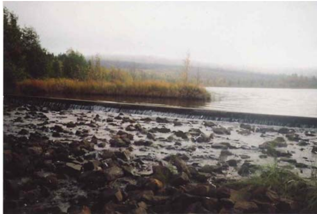
Kuva 9 Sirniönjärven säännöstelypato, taustalla Mustavaaran vanha kaivosalue
