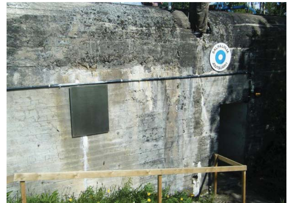
Kuva 25. Joutsijärvellä sijaitseva Salpalinjan betonikorsu.
