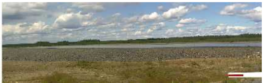
Pampalon selkeytysallas puuttomine reuna-alueineen Poikopääntieltä.
