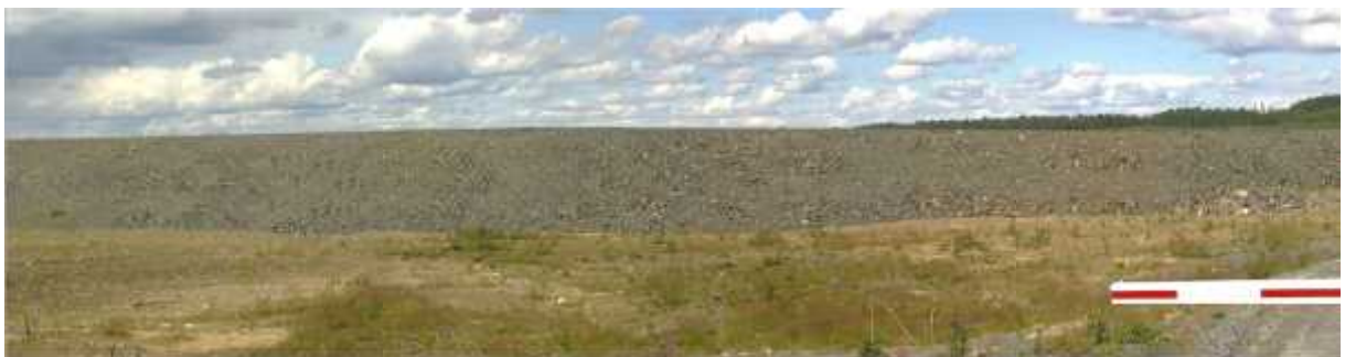
Kuva 56. Kuvasovite tilanteesta, kun nykyistä patoa on korotettu 6 metrillä.
