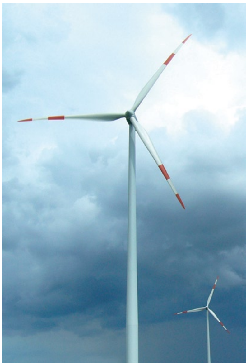
■ Kuva 3-10. Esimerkkikuva tuulivoimalan päivämerkinnöistä.
