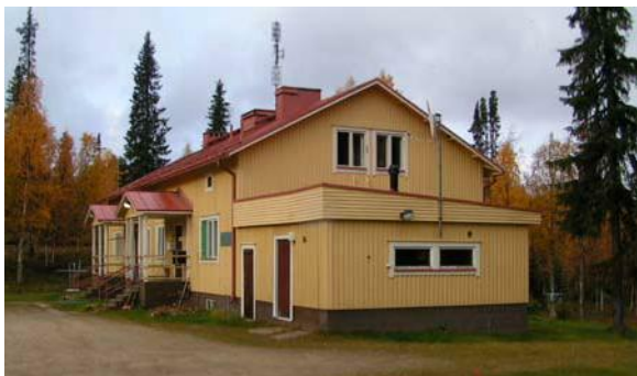
Ainijärven rajavarttioasema, päärakennus
