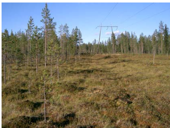
Kuva 5/23 Monin paikoin putkilinja noudattelee voimajohtokäytävää ja kulkee rämepinnoilla
