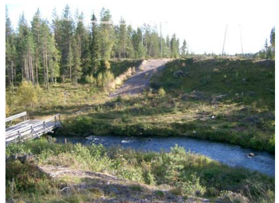
Kuva 5/24 Meskusvaarantien eteläpuolella putkilinja kulkee johtokäytävässä kangasmaalla.
