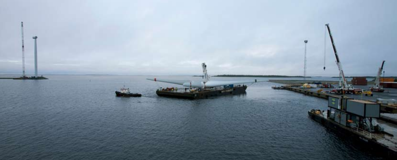
■ Kuva 4-42. Merituulivoimalaitoksen rakentaminen edellyttää tuulivoimalan osien ja nostokaluston kuljettamista suurilla aluksilla.
