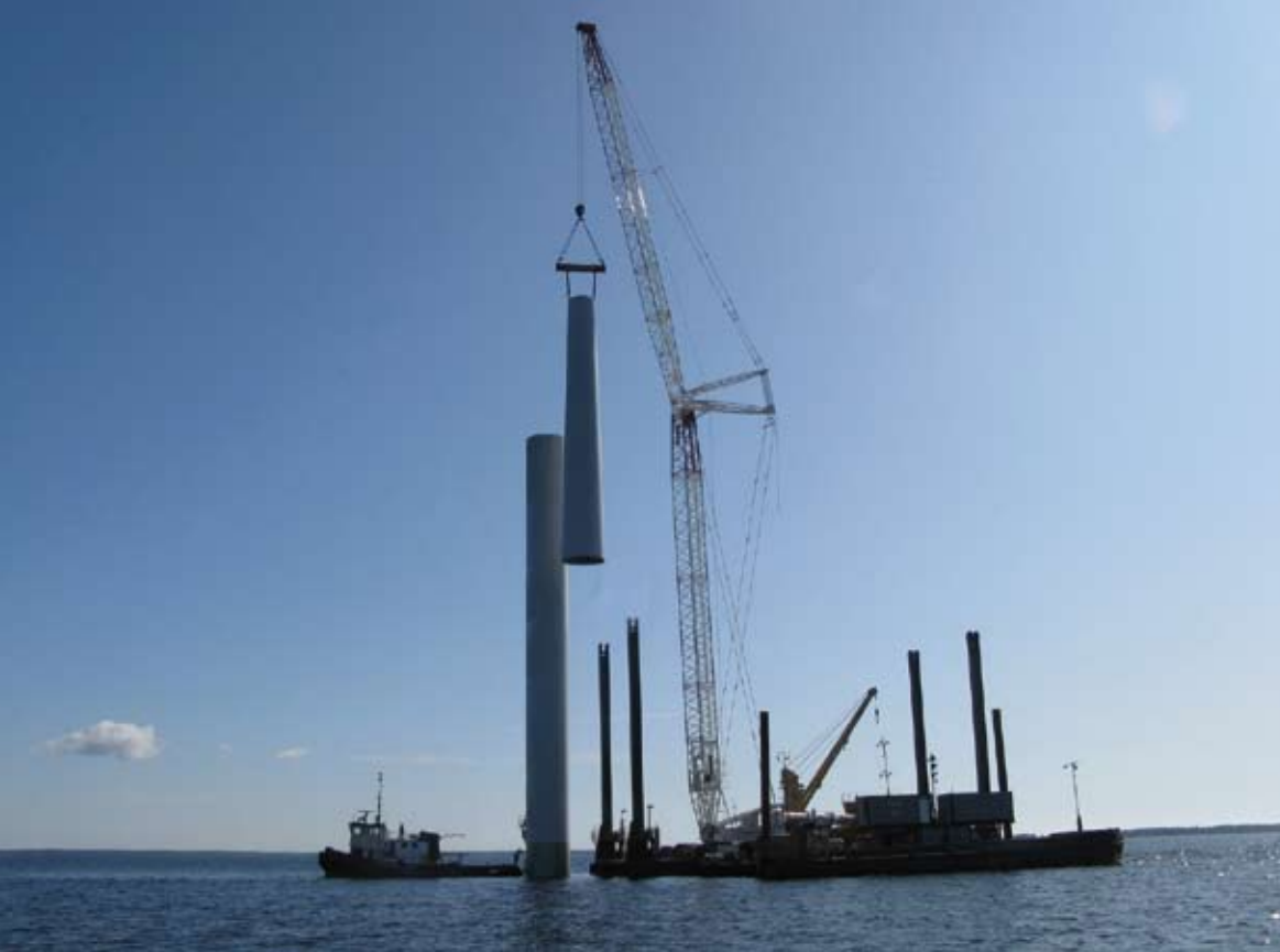
■ Kuva 2-25. Voimalaitostornin pystytyskäynnissä Ajoksen koeperustushankkeessa kesällä 2009.
