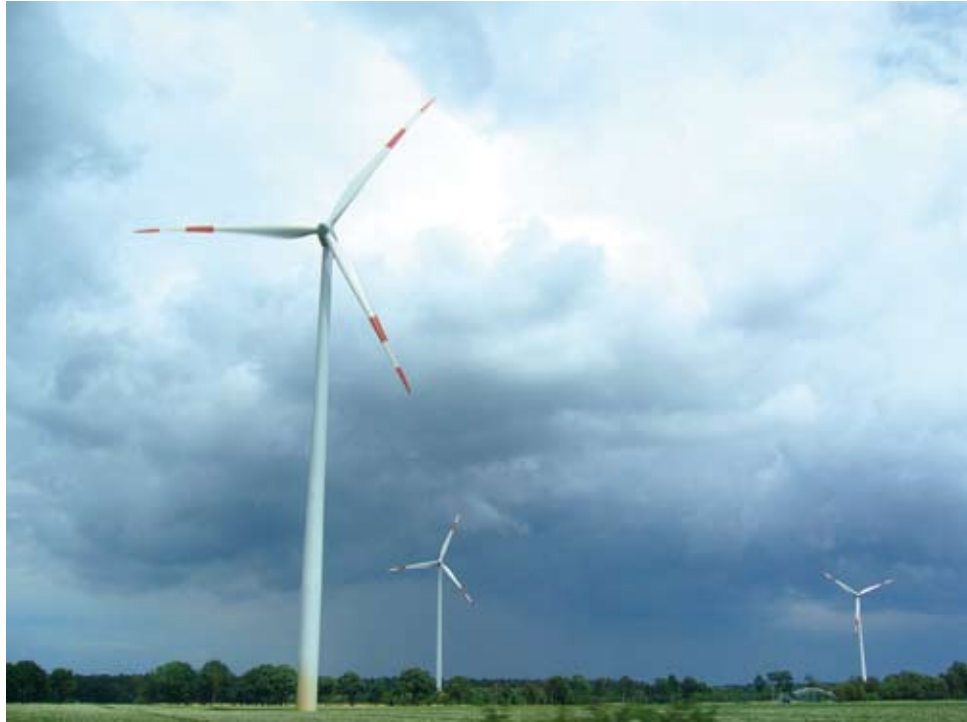
■ Figur 2-16. Exempel på dagmarkeringar på ett vindkraftverk.
