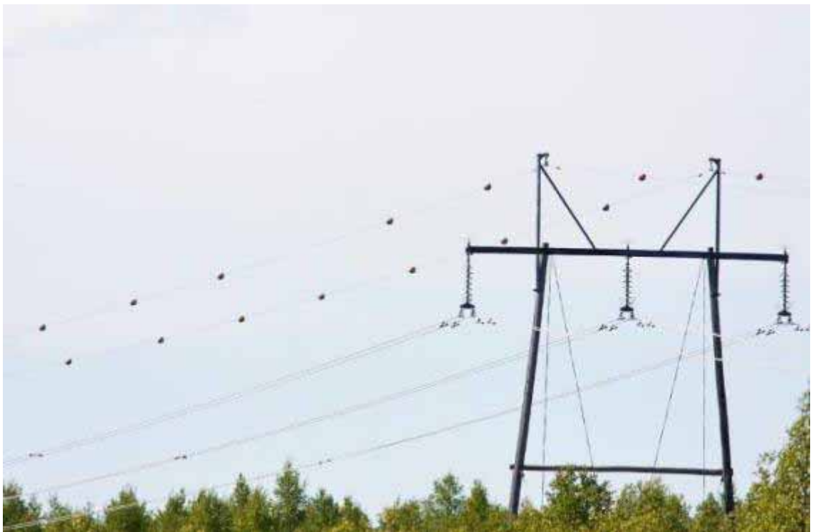
Kuva 12–43. Huomiopallojen sijoittaminen voimalinjojen yläpuolisiin ukkosjohtimiin lisää ohuiden lankojen näkyvyyttä ja vähentää osaltaan lintujen törmäysriskiä (kuva ©Ville Suorsa).
