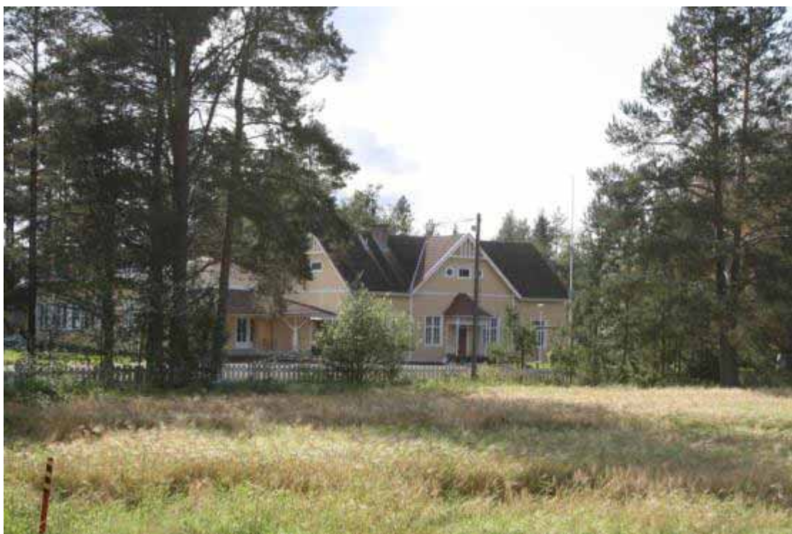
Kuva 9–2. Kopsan käytöstä poistettu koulurakennus edustaa vanhaa rakennuskantaa ja on kulttuurihistoriallinen kohde.
