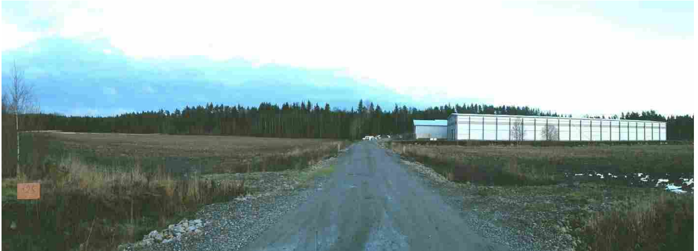
Kuva 45. Hankevaihtoehto VE1 hankekiinteistön tieliittymän kohdalta (AIRIX Ympäristö, 2012).
