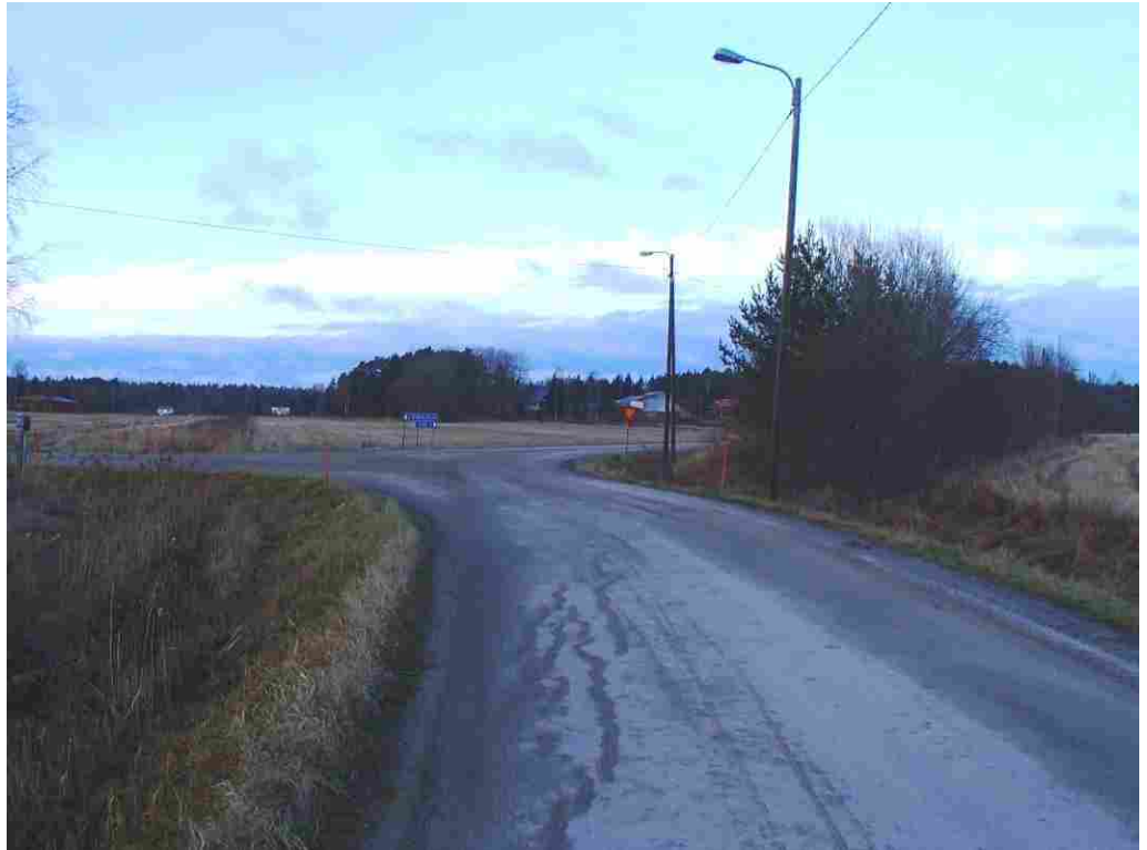
Kuva 18. Palolaistentien ja Kivikyläntien risteys.
