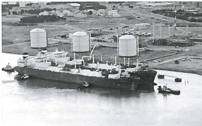
Kuva 5-12. LNG-alus kiinnittyneenä kelluvan varastoaluksen (FSRU) kylkeen ( http://www.vesseltracker.com ). Taustalla pienimittakaavaisen LNG-termiinalin varastosäiliöitä (20 000 m 3 )
