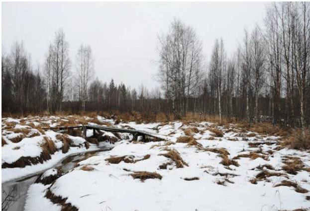
Kuva 9. Silta (polku Seluskanharjulta Navettamaalle).
