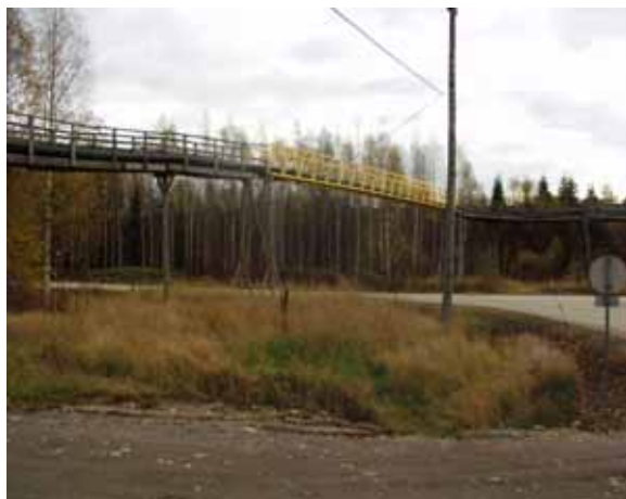
Kuva 22. Maantie 7630:n yli johtava rikastushiekkaputkiston silta.
