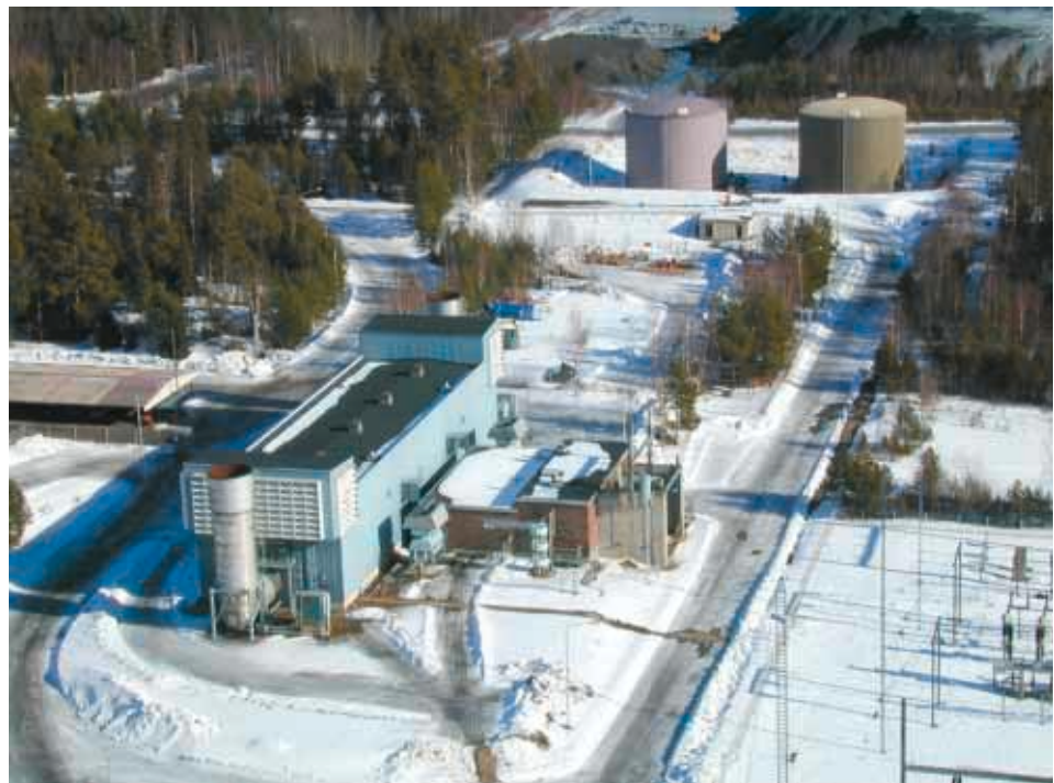
Kuva 4.2. Fingridin Kristiinan kaasuturpiinivoimalaitos, jonka kokonaisnettoteho on noin 2 x 30 MW.
