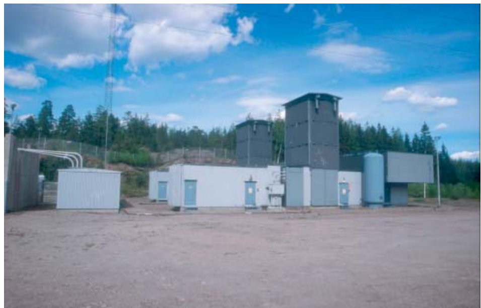
Kuva 4.1. Fingridin Tolkkisten kaasuturpiinilaitos, jonka kokonaisnettoteho on noin 2 x 20 MW.
