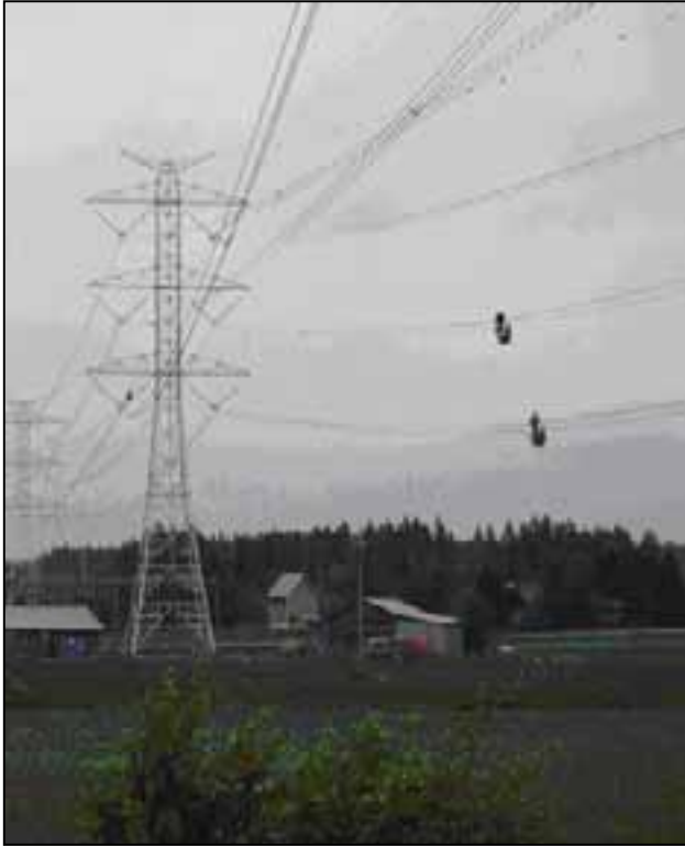
Kuva 10. Johdinten välisiteiden asennusta.
