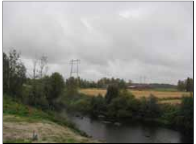
Kuva 115. Voimajohtoreitti ylittää Vääräjoen Tyngällä (VE A).
