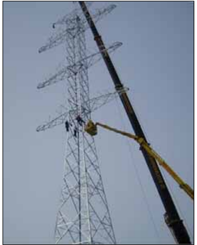
Kuva 9. Jännitetasoltaan 400 kV kahden voimajohdon Tannenbaum-tyyppisen pylvään pystytystä nostureilla.
