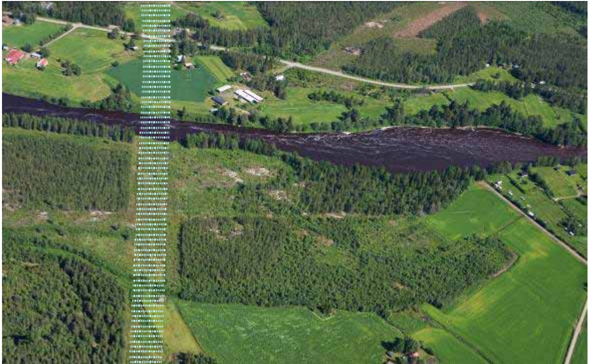
Kuva 30. Nykyiset voimajohdot halkovat Pyhäjokivarren maakunnallisesti merkittävää maisema-aluetta.
