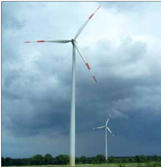
Kuva 6-11 Esimerkkikuva tuulivoimalan päivämerkinnöistä.
