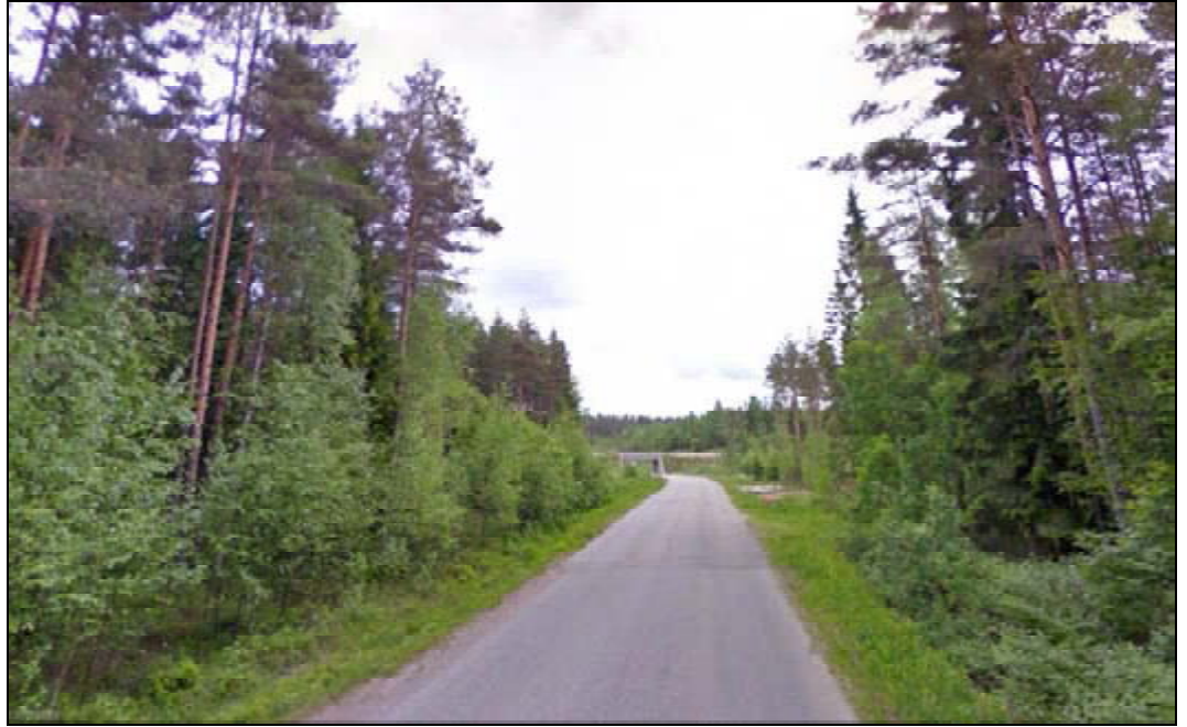
Kuva 73. Lemuntien päässä sijaitsee rautatien alikulkutunneli. Tunneli sijaitsee noin 1,2 km:n päässä hankealueelta pohjoiseen. Tunnelin jälkeen kuljetusreitti jatkuu noin 700 metriä Pysäkitietä pitkin Kouvolantielle.
