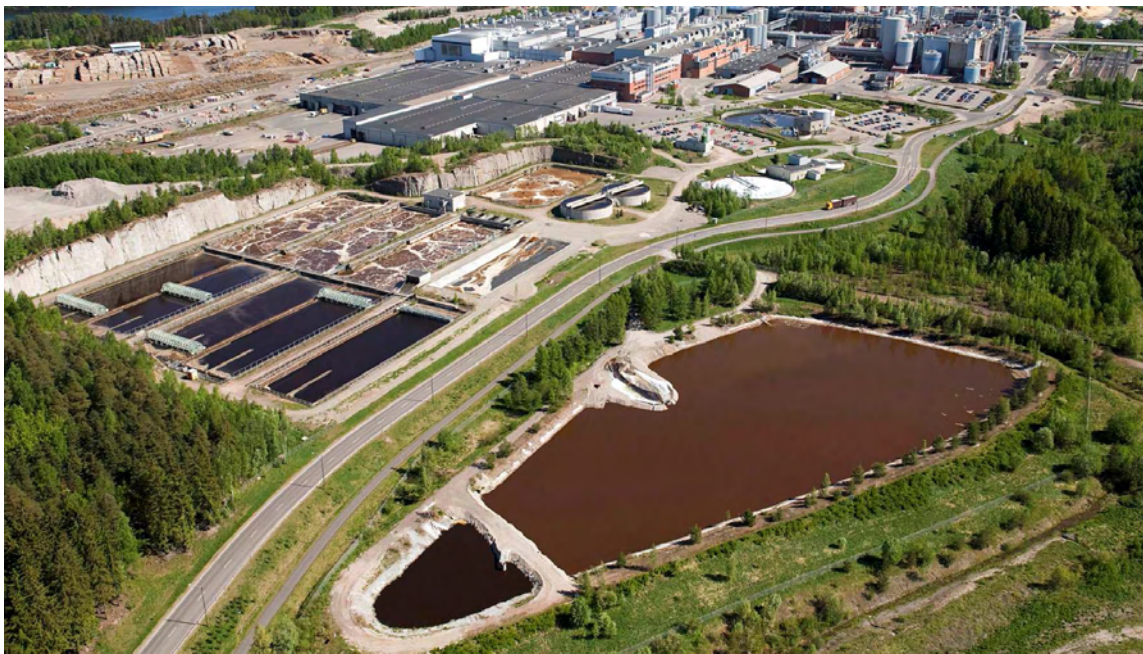
Kuva 6 Kymin jätevesilaitos. Etualalla 50 000 m 3 :n varoallas, tien yläpuolella aktiivilietelaitos.
