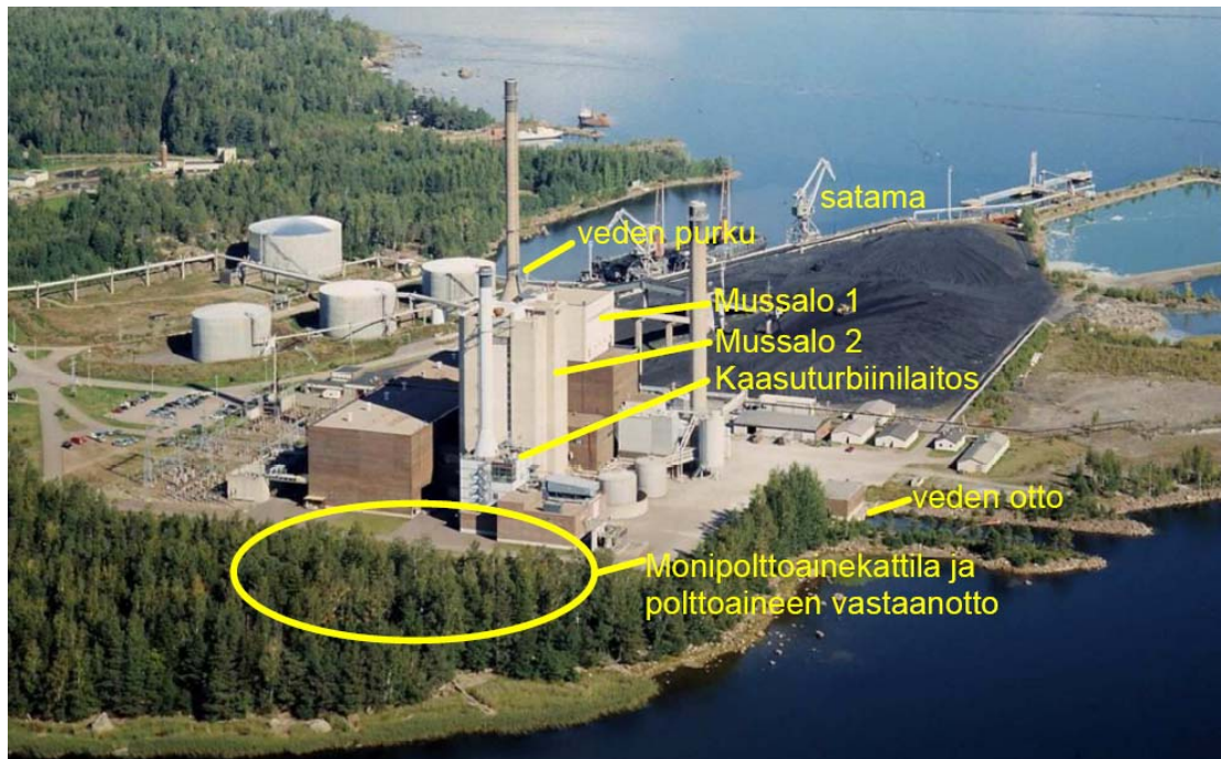
Kuva 2. Mussalon voimalaitosalue. Kuva: Pohjolan Voima Oy.
