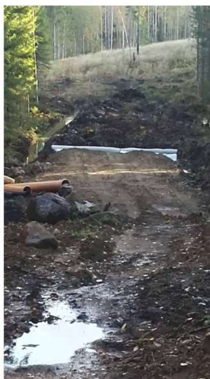
Kuva 45. Louhintahiekan muokkauksia Linnaojaan ja siihen johtaviin ojiin hankealueen päädyssä
