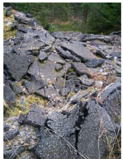
Kuva 8. Louhintahiekan toimesta Raalan hankealueelle tuotua ylijäämämaata (kuvassa asfalttia)
