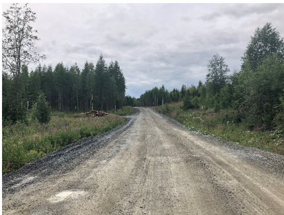
Kuva 62 Rötköntie Uusi-Kuruntieltä länteen
