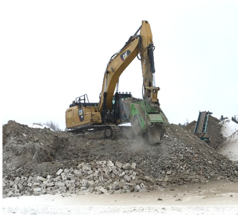
Kuva 12 Betonijätteen murskausta
