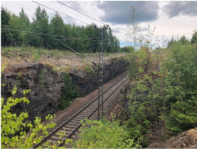
Kuva 49 Tampere-Seinäjoki rautatie hankealueen kohdalla
