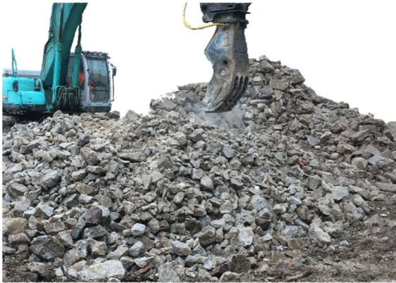
Kuva 11 Betonijätteen pulverointia
