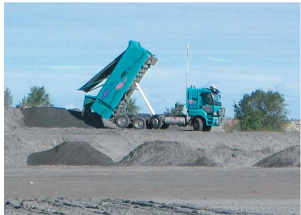
Kuva 4-4 Tuhkakuorman tyhjennys Lålbyssä
