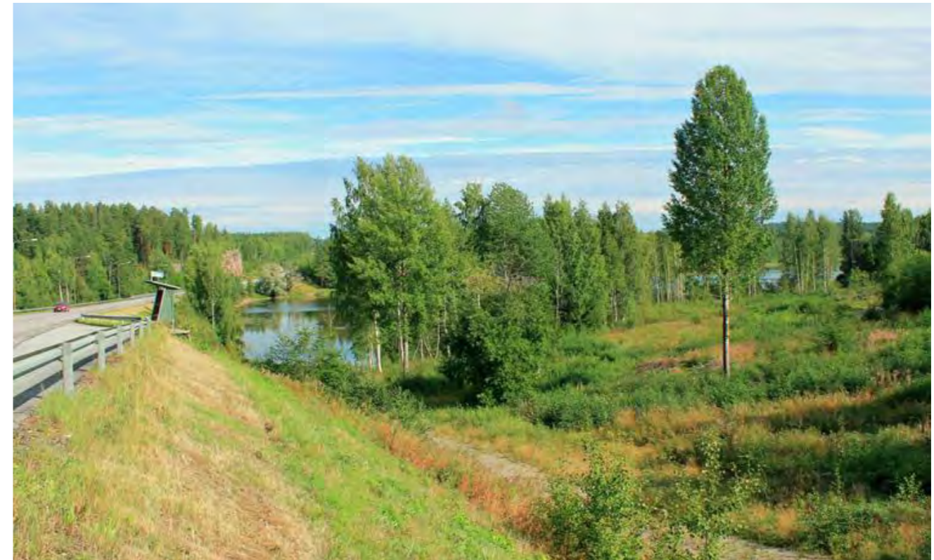
Kuva 12.14. Uusi siltayhteys sijoittuu kuvassa nykyisen valtatie oikealle puolelle, ja kohoaa enimmillään 17 metrin korkeuteen vesipinnasta.
