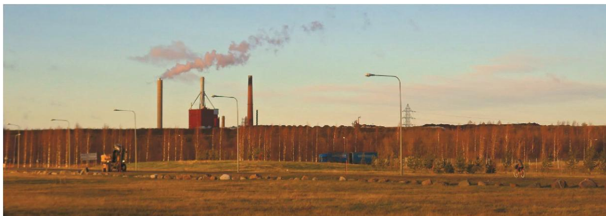
Kuva 85. Sataman pohjoispuolella sijaitseva täyttömäki ja sen takana sijaitseva tehdasalue.
