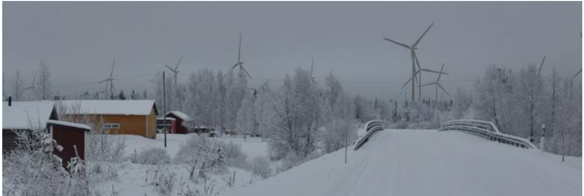
Kuva 69. Näkymä Hyyrintieltä Laasuvannon ylittävän sillan kohdalta kohti Yli-Olhavan tuulivoimapuistoa. Kuvassa on esitetty haruksellinen voimalatyyppi. Maisemavaikutukset Hyyryn kylään on arvioitu suurimmiksi. Kuva havainnollistaa likimääräisesti, millainen maisemavaikutus suurimmillaan on kylän alueella niillä paikoilla, missä peittävää lähipuustoa tai rakennuksia ei ole.
