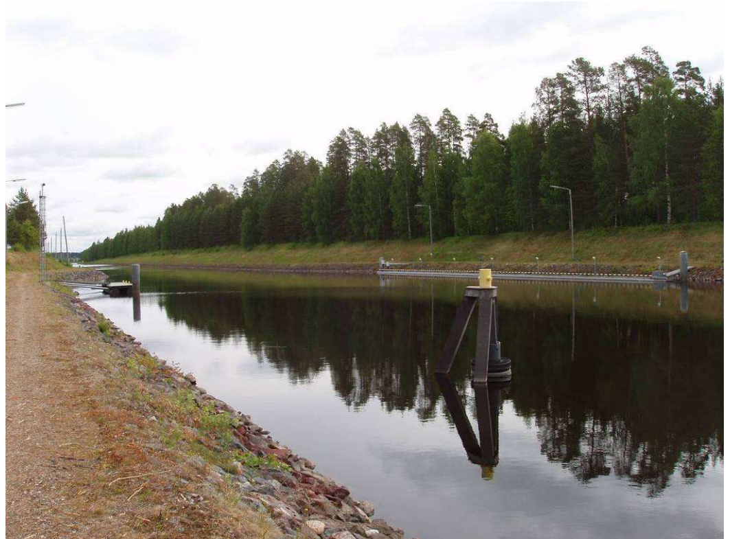
Kuva 30. Siirtoviemäri alittaa Nerkoon kanavan.
